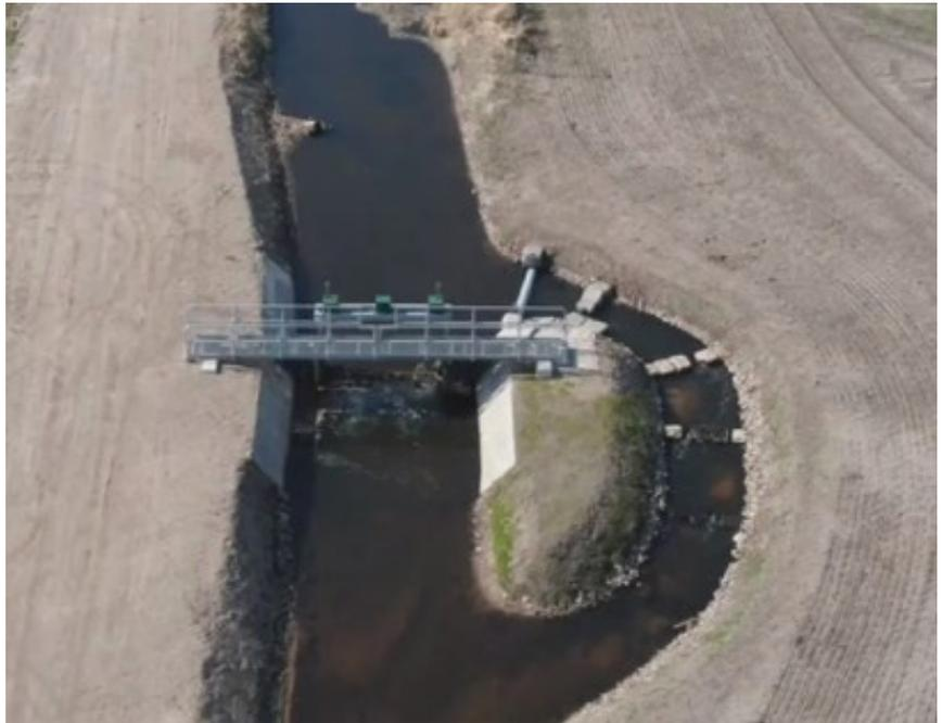
**Abbildung 11:** Stauanlage mit Fischpass in der Tanger (Sachsen-Anhalt) zur Regulierung der Wasserstände (Quelle: mdr)
