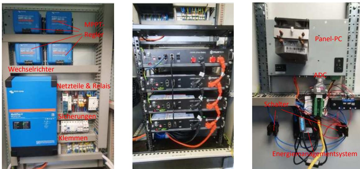
**Abbildung 15:** Energiesystem – Umrichter (links) – Energiespeicher (mitte) – Steuerung (rechts)
