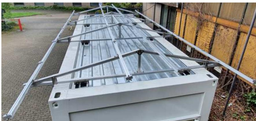
**Abbildung 17:** PV-Aufständerung im montierten Zustand
