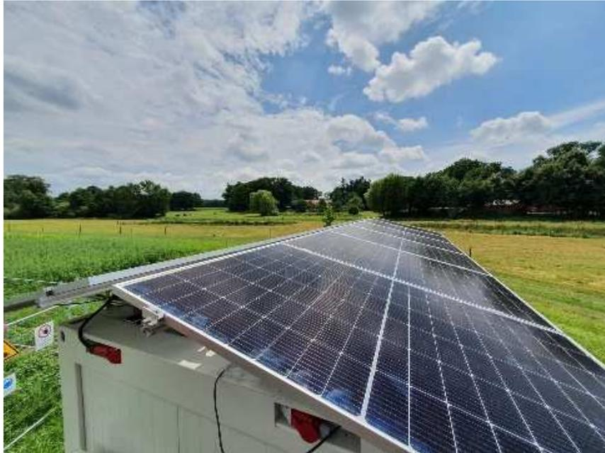
**Abbildung 18:** Montierte PV-Anlage auf der Ladestation
