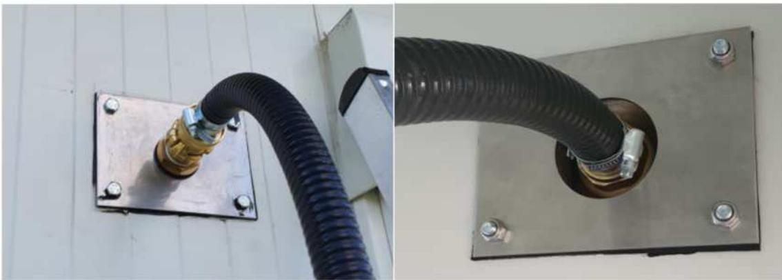
**Abbildung 29:** Wasseranschluss am Stationscontainer - außen (links) - innen (rechts)
