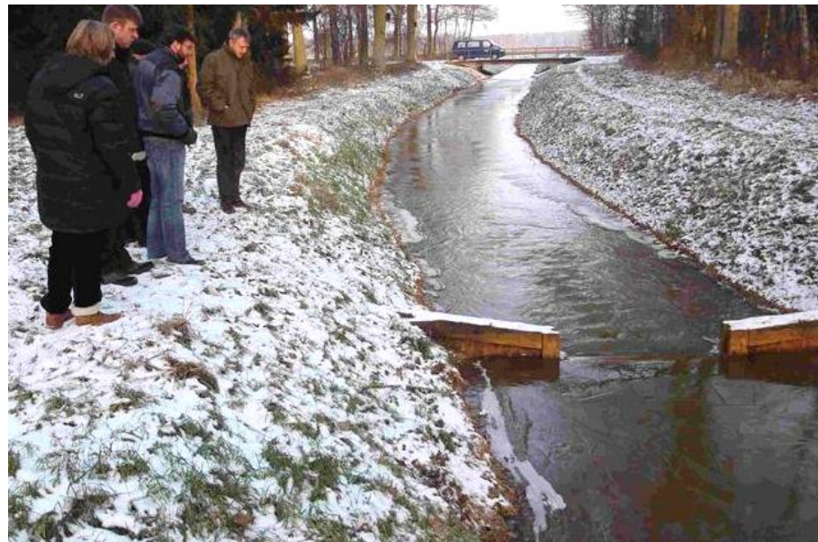
Stauanlage Beispiel aus der Lucie, Wendland (Quelle:DFU)
